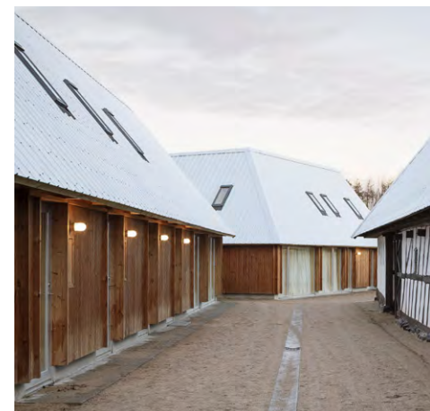
Reference: Studielandsbyen ved Aarhus er en transformation og tilføjelse af nybyggeri til en firelænget bindingsværksgård fra 1700-tallet.
