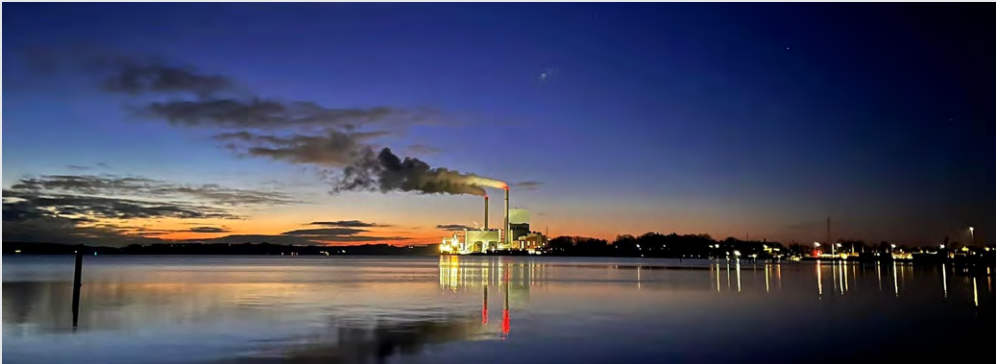
Skærbækværket set fra syd.
